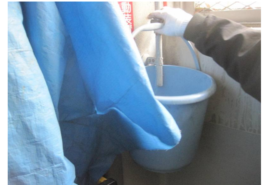
〈各区域手動起動装置から泡水溶液抜取〉
