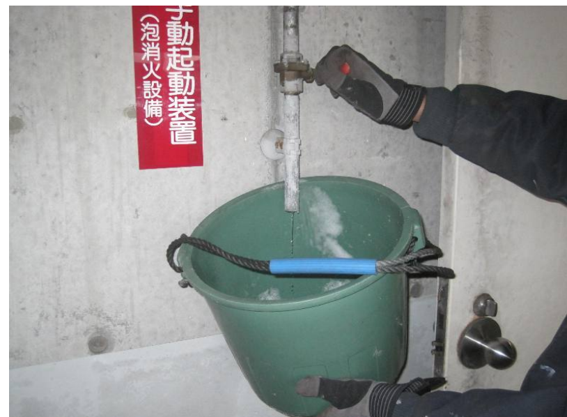
〈各区域手動起動装置から泡水溶液抜取〉
