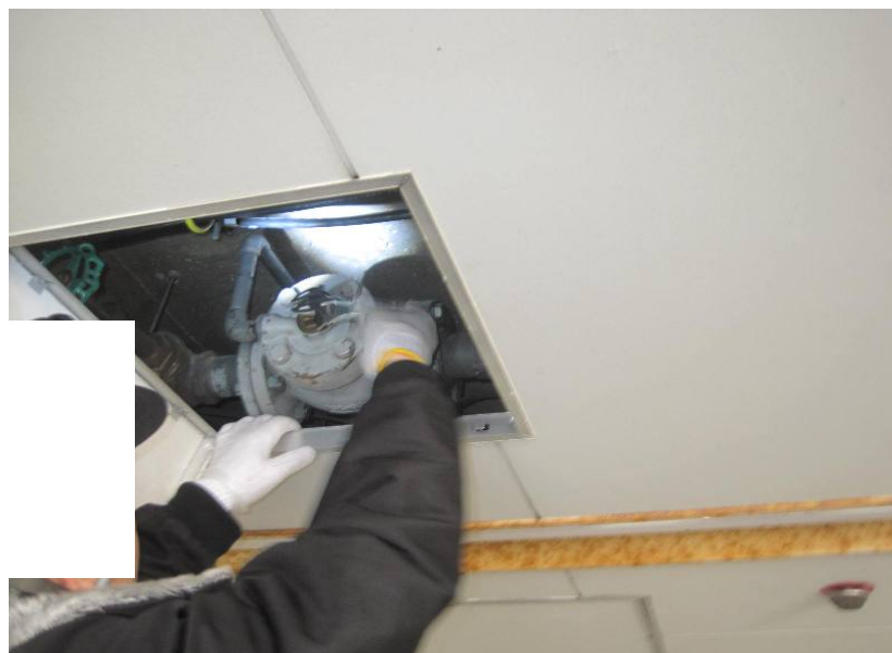
〈感知ヘッド側配管薬剤採取〉
