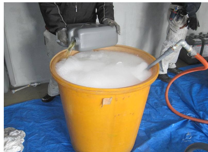
新規泡消火薬剤注入
