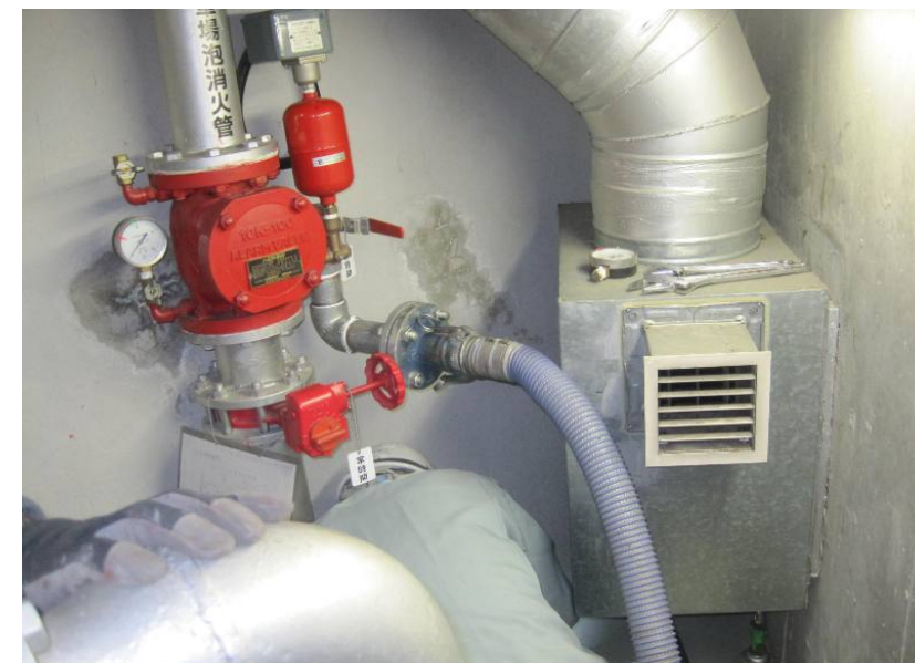
〈アラームバルブ薬剤水溶液採取〉
