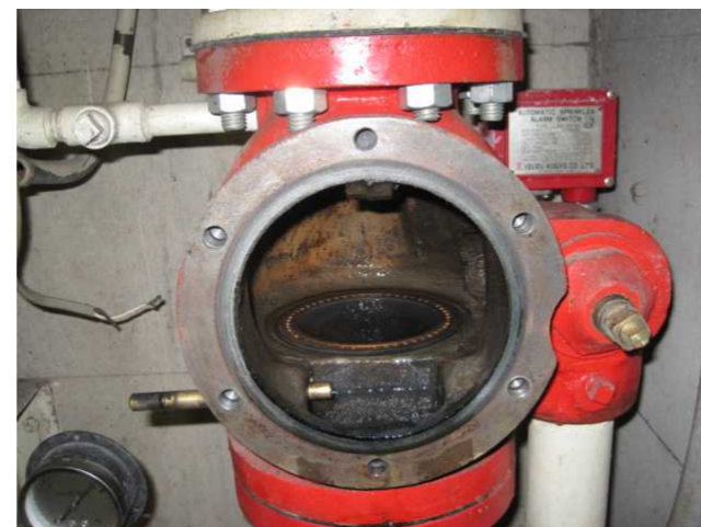
ディスク(弁座)を取り外しています
