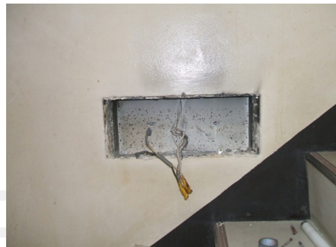
既設誘導灯撤去
