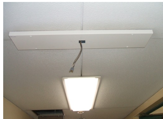
リニューアルプレート取付
