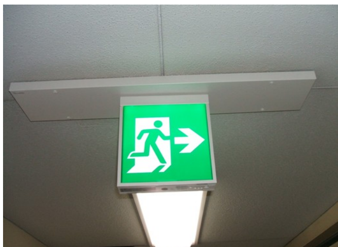
新誘導灯取付完了
