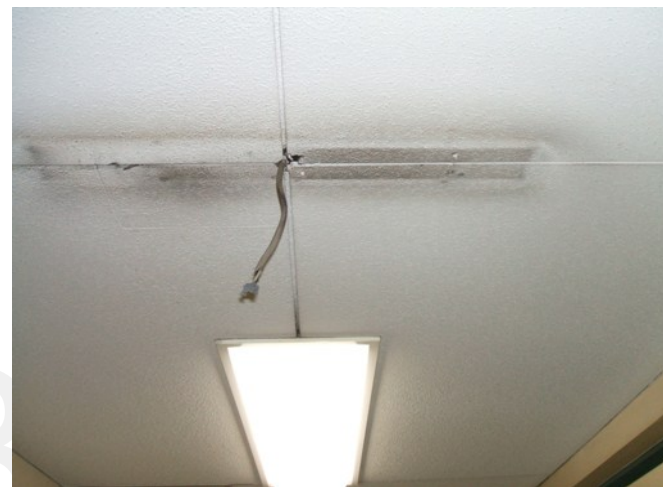
既設誘導灯撤去
