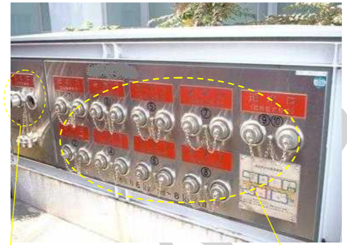
設置例 連結送水管用送水口 連結散水用送水口
