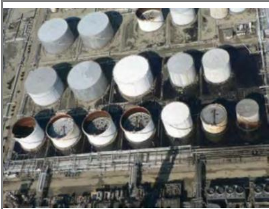
配管の破損により 防油堤内に重油が大量に流出 (出典：仙台市消防局)
