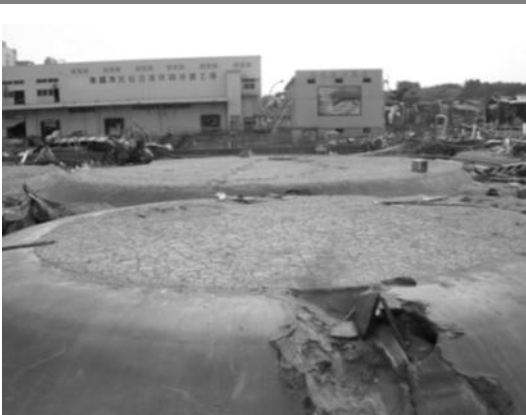
津波によりタンクが移動した タンク基礎 (出典：消防研究センター)
