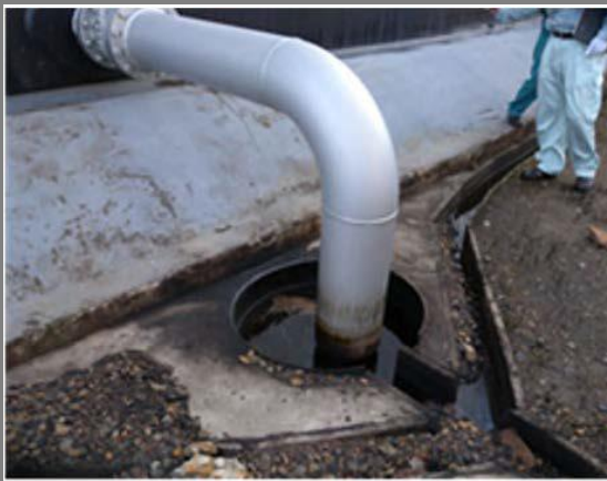
スロッシングにより浮き屋根上に溢出し た油がルーフドレン配管から流出 (出典：消防研究センター)
