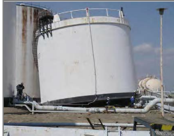
津波により浮上・移動したタンク (地震時は空) (出典：消防研究センター)
