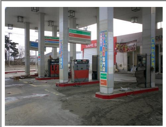
固定給油設備が欠損したアイランド (出典:危険物保安技術協会)
