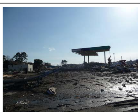
七ヶ浜町の被災状況 (出典:全国石油商業組合連合会)
