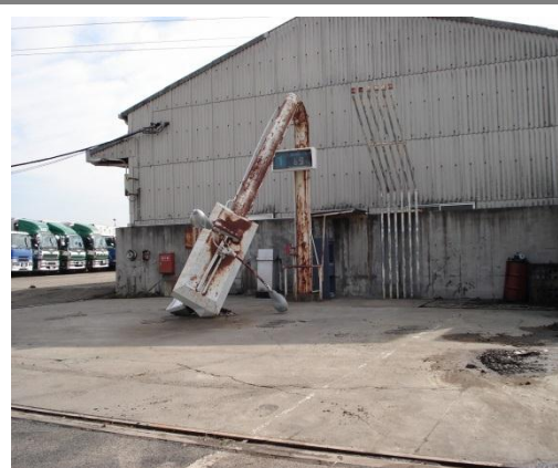
地盤面及びアイランドに入った地震による亀裂 (出典：全国危険物安全協会)
