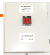
火災通報装置が連動起動
